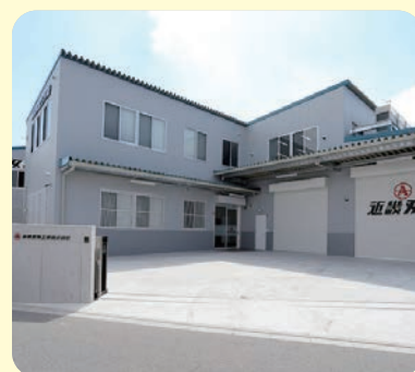
第二工場外観
